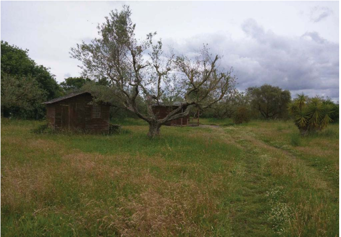
Foto 3 - Costruzioni in legno – Realizzate in assenza di titolo edilizio
